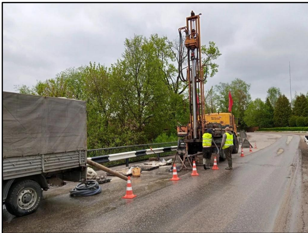
Рисунок 4.1 – Буровая установка УРБ-2А2 на базе а/м КамАЗ
