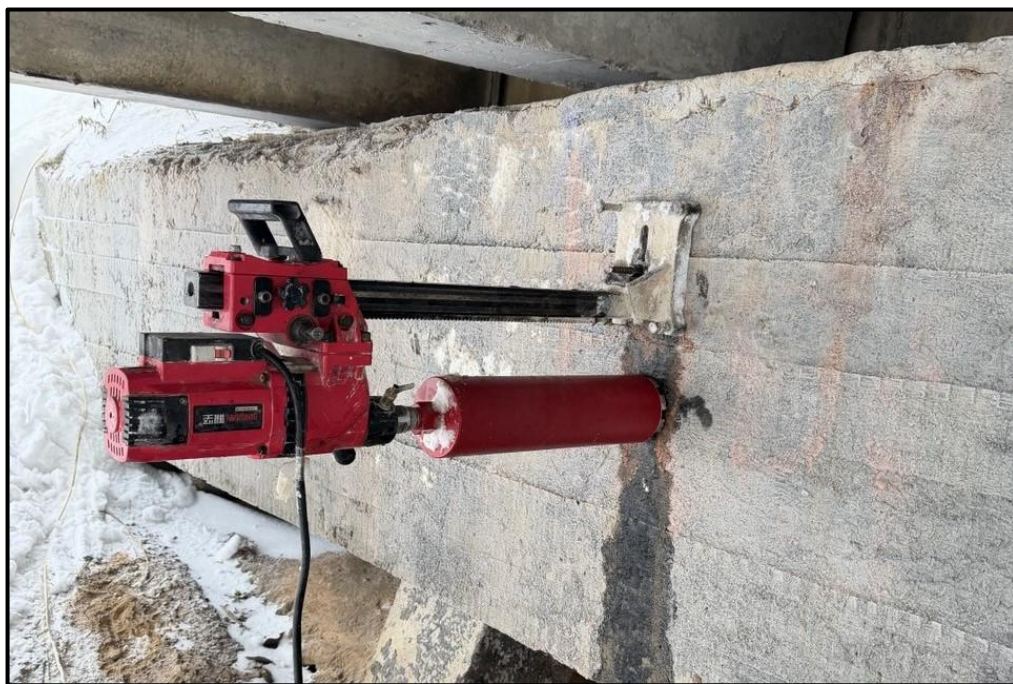
Рисунок 4.2 – Малогабаритная алмазная буровая установка
