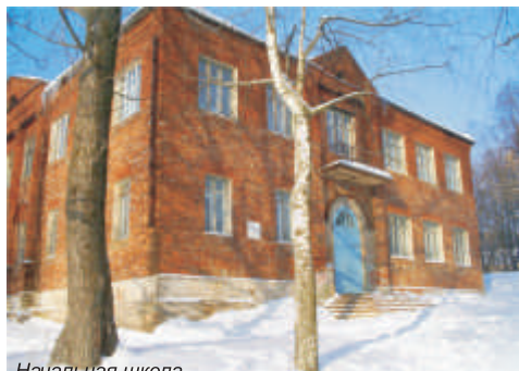
Начальная школа (бывшее здание уездного училища начало XIX в.)
